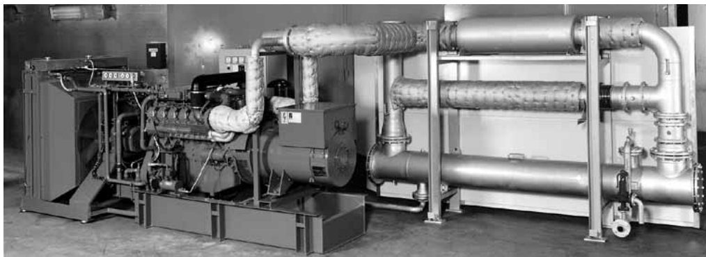
Рис. 2.23. Блочная теплоэлектростанция фирмы ABZ
